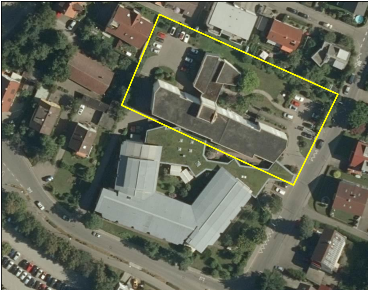
Abb. 2: Blick auf die überplante Fläche mit nördlichem Gebäude (gelb, grob umrissen). Im Süden die Moosbruggerstraße und im Osten die Burachstraße (Kartengrundlage: LUBW, 17.05.20).
