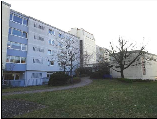
Abb. 4: Blick von Nordosten auf den Gebäudeteil mit Kapelle (rechts im Bild), der abgerissen werden soll.
