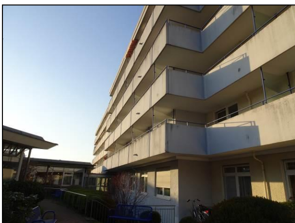
Abb. 8: Südseite des Gebäudes mit Balkonen. Links im Bild kleiner Bereich mit Sitzbänken.
